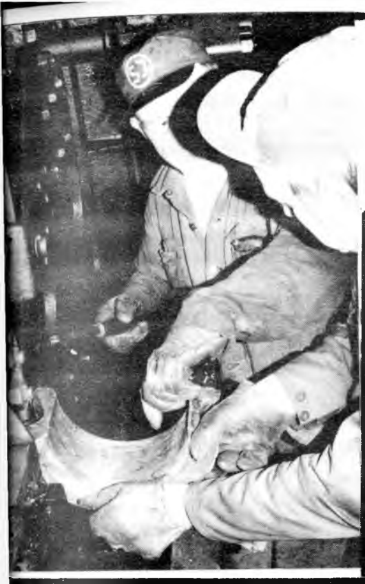
Kvällsarbete, inskaivning av vevstakslagret. Gunnar Wallin håller i ← "operationskniven" (skavstålet) en kväll i början av maj 1979. Foto: Rolf Stén
